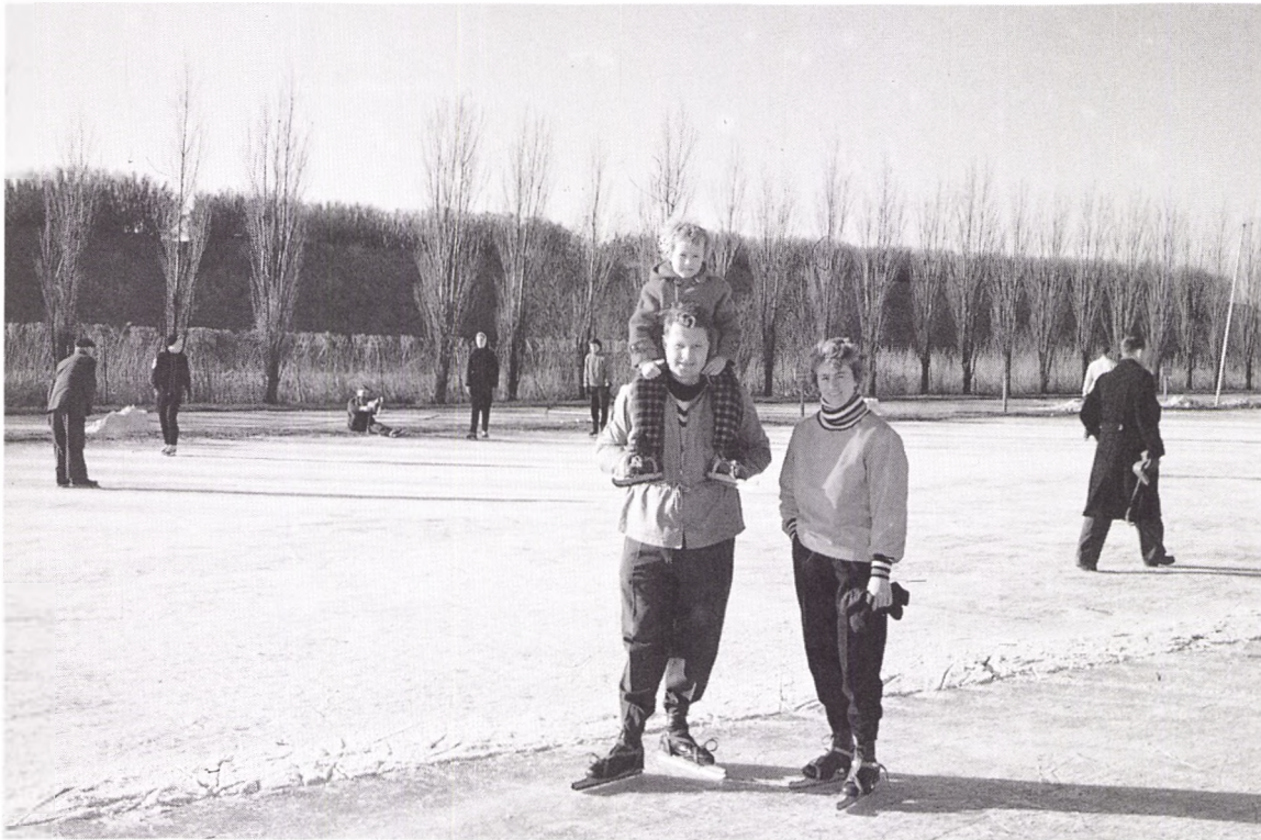
De familie Warners op het traject van de ijsbaan dat later moest worden onteigend voor het aanleggen van de rijksweg A4.
