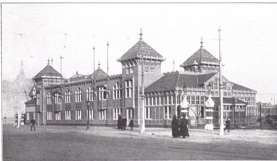
Het nieuwe clubgebouw. Op de achtergrond het Stedelijk Museum.
