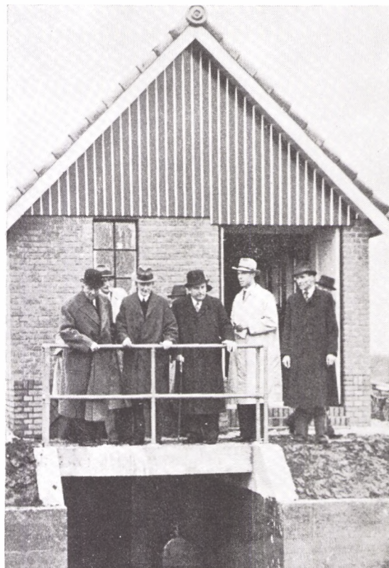
Werkzaamheden aan het poldergemaal, benodigd voor het nieuwe IJclubterrein bij de Schinkel worden door het bestuur bekeken v.l.n.r. de heren Wagener, Stroeve, Louët Feisser, de journalist Nijland, Van Haften en een uitvoerder.
