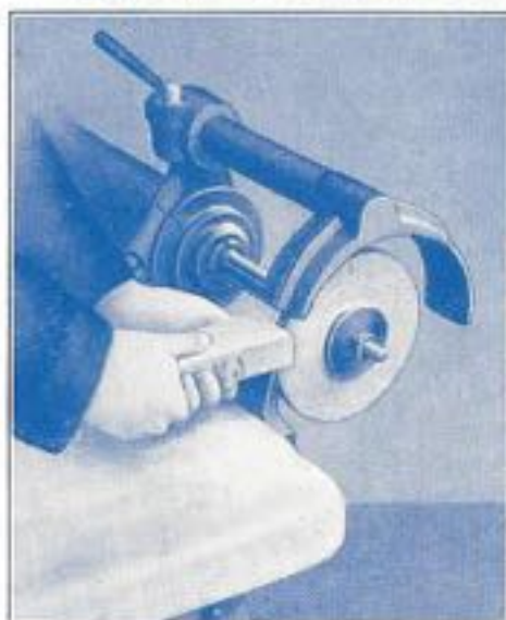
Abbildung 3 Abritzen des Schleifsteines
