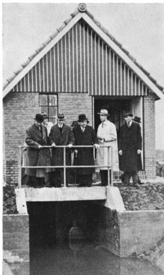
In 1936 bezichtigden enige bestuursleden van de A.I.J.C., in gezelschap van de journalist Nijland, de werkzaamheden aan het poldergemaal. V.l.n.r. de heren Wagener, Stroeve, Louët Feisser, Nijland, Van Haaften en een der uitvoerders.
