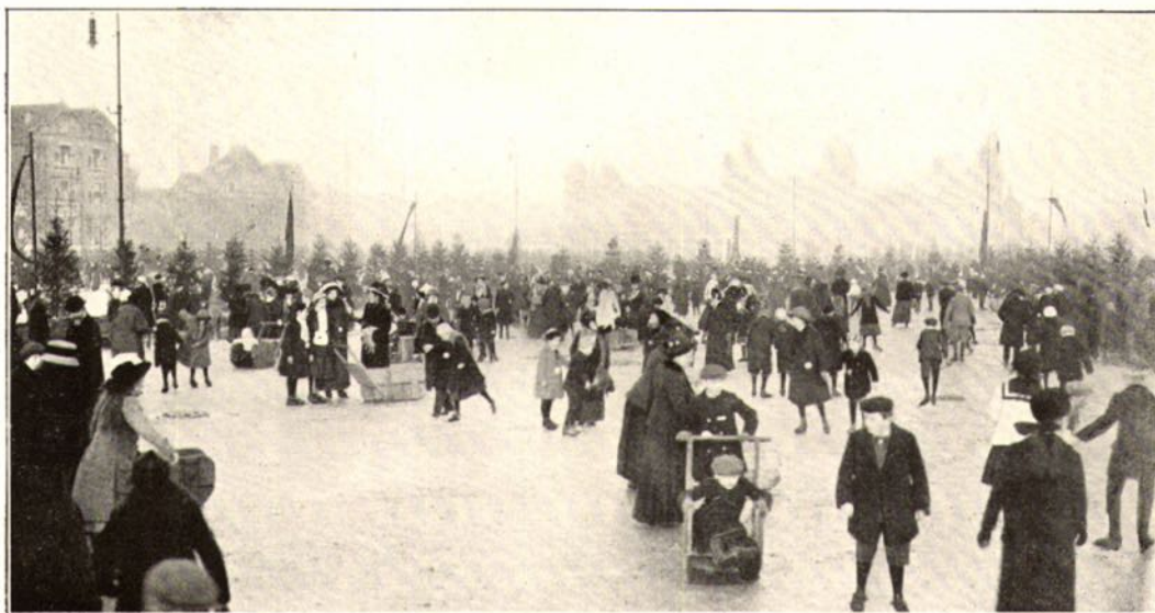
DE KINDERBAAN. FEBRUARI 1912
